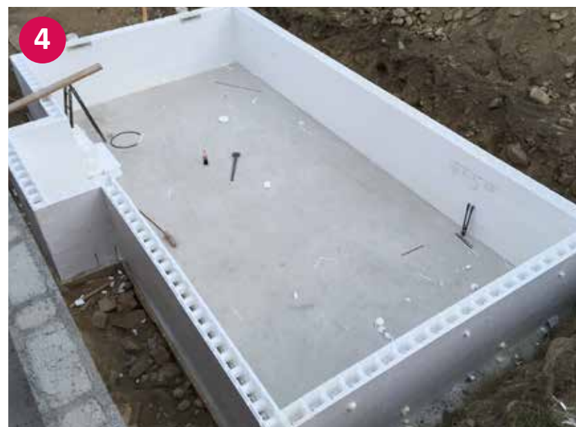
▲ Že sestavljen stiroporni bazen – brez betonskega polnila
