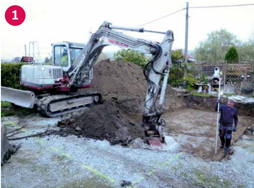
▲ Izkop gradbene jame
