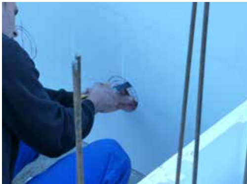
▲ Izrez za dovodno šobo
