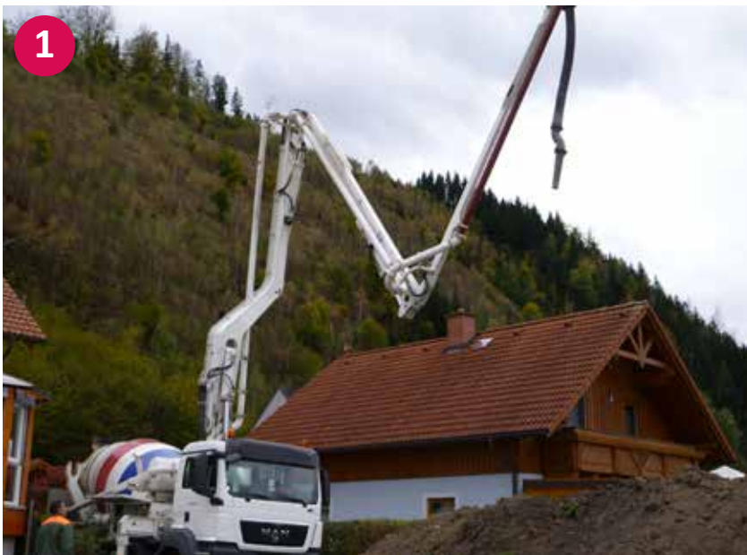
▲ Betonska cisterna z betonsko črpalko
