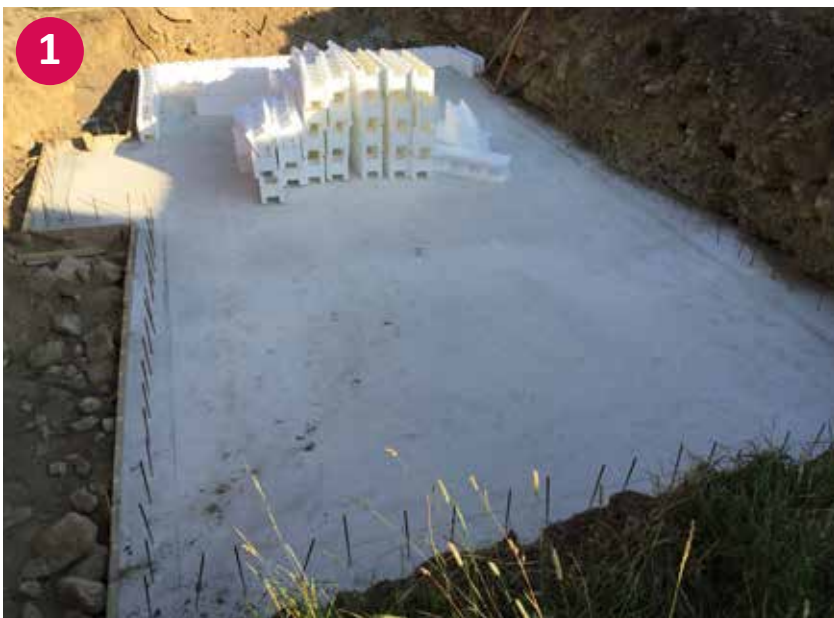
▲ Dokončno posušena talna plošča
