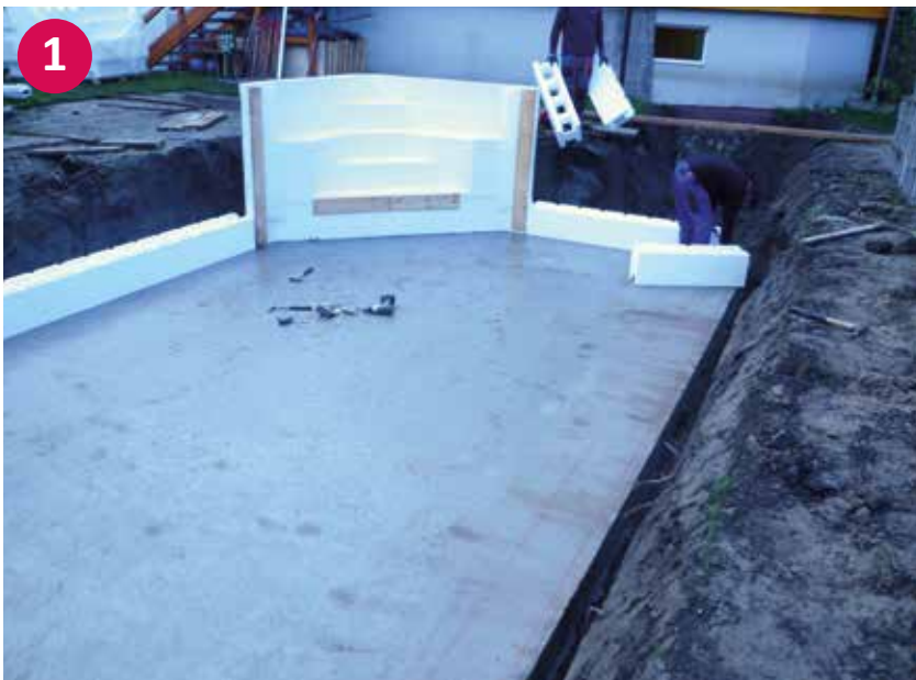
▲ Kotno stopnišče s prvo vrsto stiropornih zidakov
