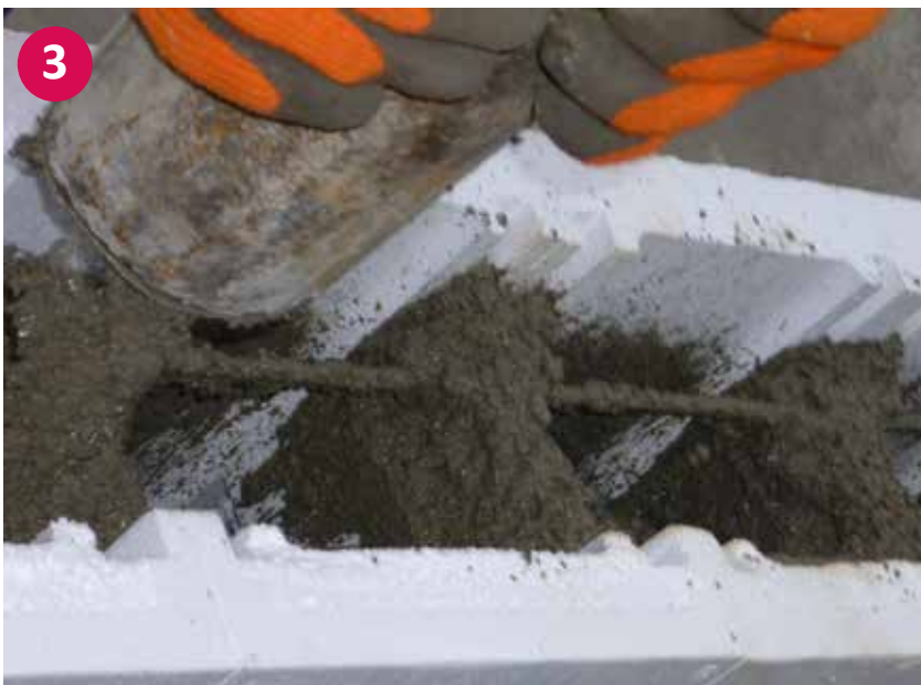
▲ Detajlni pogled: polnjenje stiropornih zidakov z betonom
