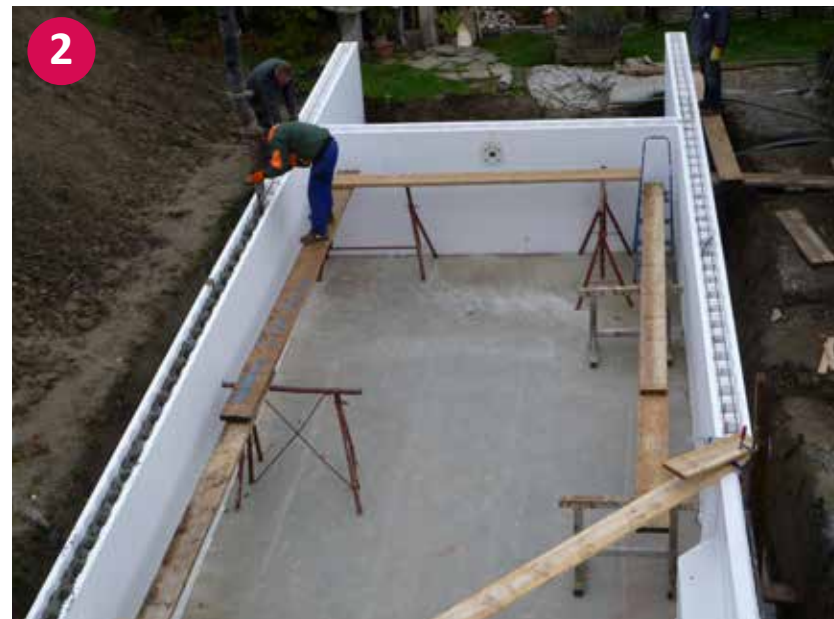
▲ Polnjenje stiropornih zidakov z betonom
