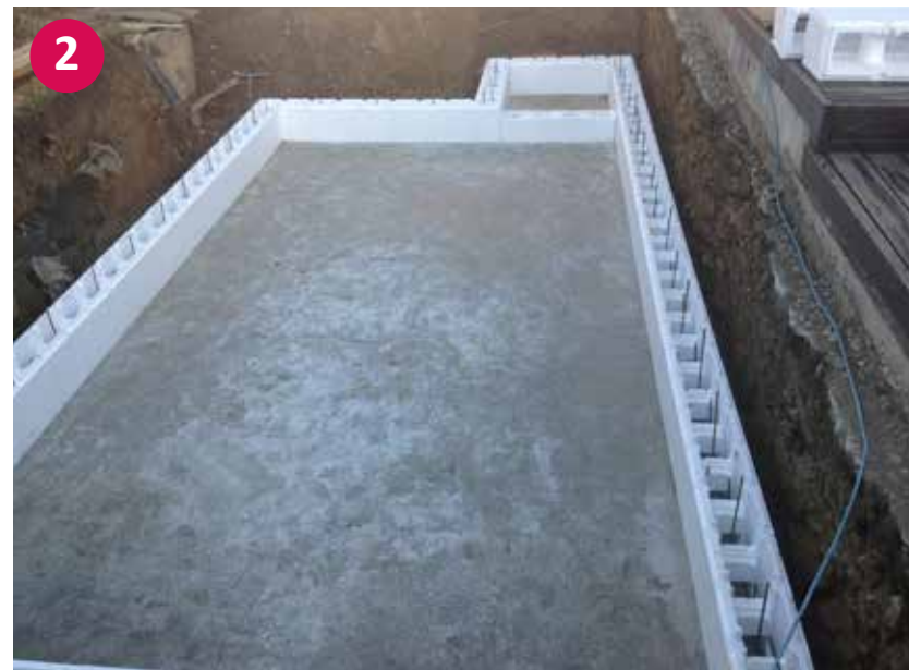
▲ Postavitev prve vrste opek iz stiropora
