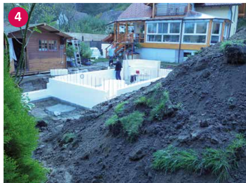
▲ Postavljen stiroporni bazen s kotnimi stopnicami – brez betonskega polnila
