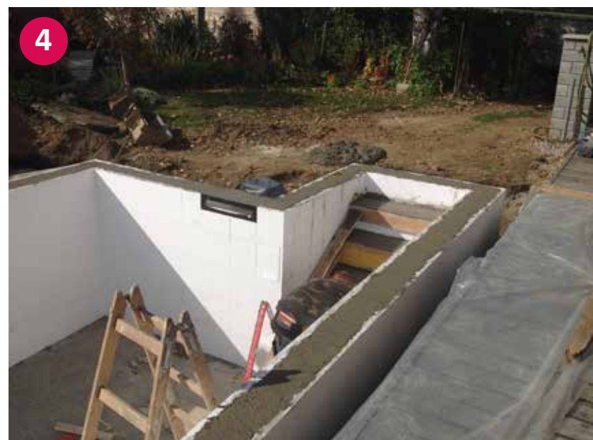
▲ Končan stiroporni bazen z betonom
