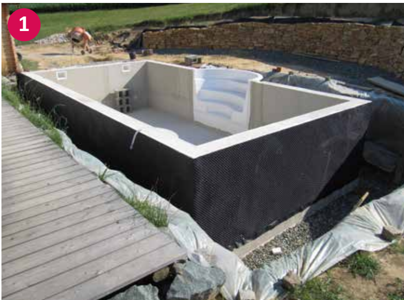
▲ Svetujemo, da vse notranje stene zamrežite in preslojite s temu namenjeno maso
