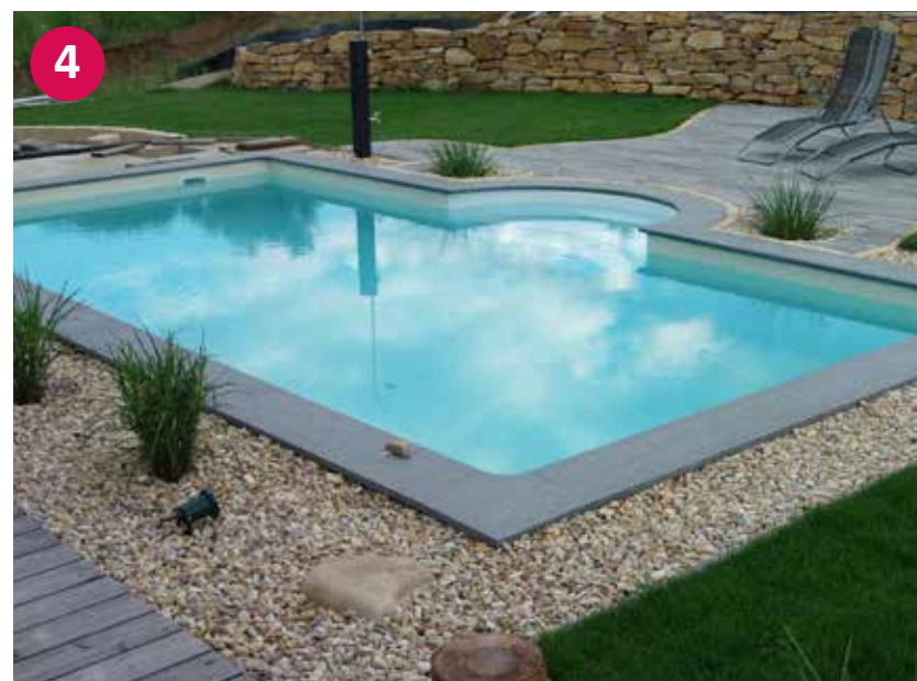
▲ Dokončan bazen iz stiropornih zidakov z rimskimi stopnicami
