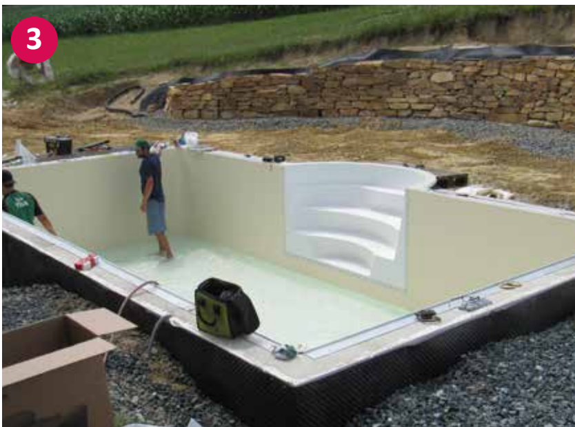
▲ Obešanje vreče iz folije in pritrdjevanje prirobnih vgradnih delov
