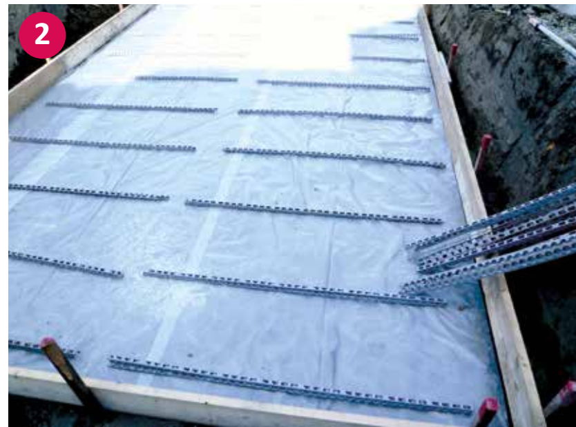
▲ Opaženje talne plošče
