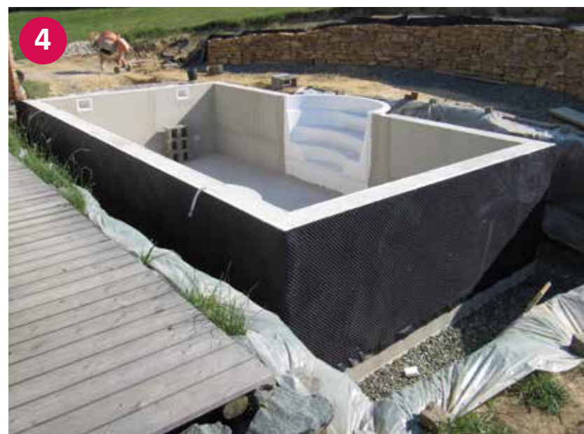
▲ Bazen iz stiropornih zidakov z rimskimi stopnicami, zglajenimi stenami in čepkasto folijo zunaj
