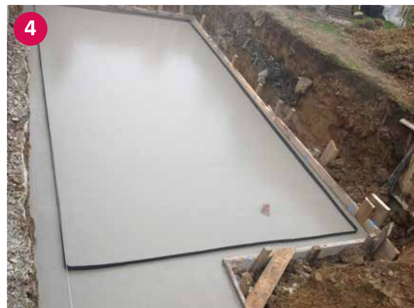
▲ Talna plošča je lahko za dodatno tesnjenje opremljena s fugirnim trakom.
