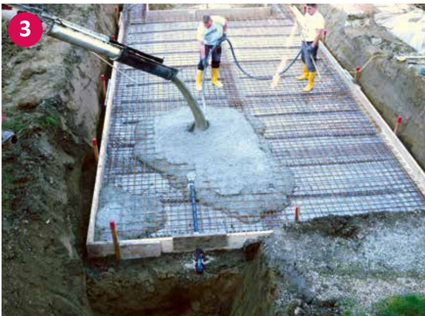
▲ Polaganje armirnega železa in betona v opažno konstrukcijo talne plošče
