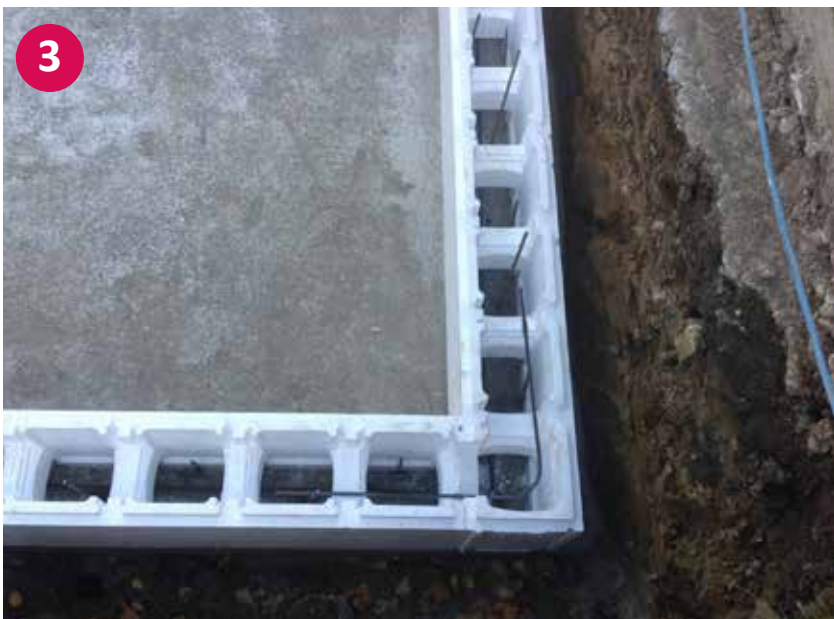
▲ Detajlna slika vogalnega spoja z železno armaturo
