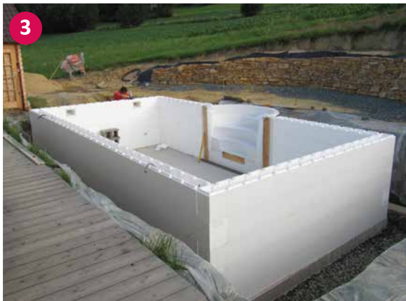
▲ Postavljen stiroporni bazen z rimskimi stopnicami – brez betonskega polnila
