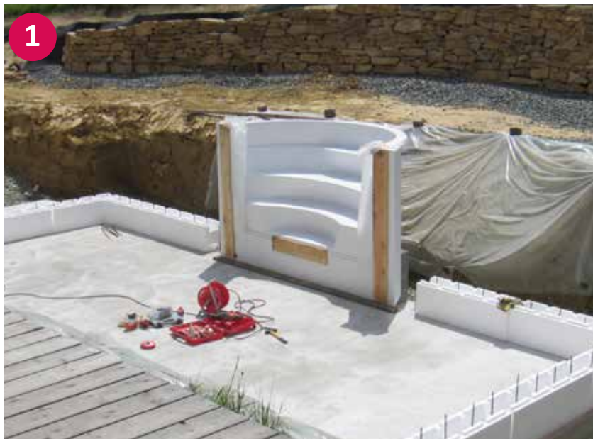
▲ Rimsko stopnišče s prvo vrsto stiropornih zidakov
