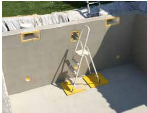
▲ Dokončana in zglajena notranja stena
